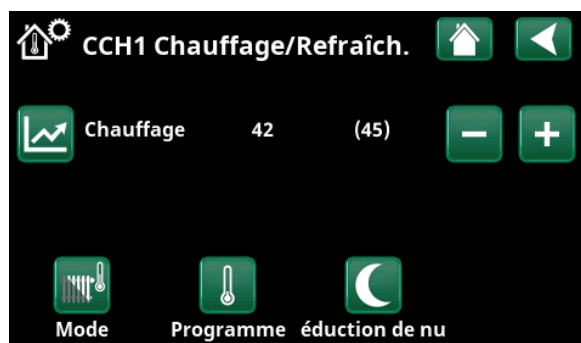
Menu « Avancé/Définir/Circ Chauffage/Circ Chauffage 1 ». Le circuit de chauffage n'a pas de sonde d'ambiance. Le valeur de consigne (température de départ 45 °C) est indiqué entre parenthèses, la température de départ actuelle de 42 °C est indiquée à gauche du point de consigne.
