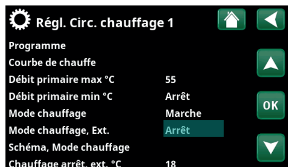
Menu : «Avancé/Réglages/Circ Chauffage/Circ Chauffage 1». Le mode de contrôle à distance «Arrêt» devient actif lorsque le bornier de connexion K24 est fermé.
