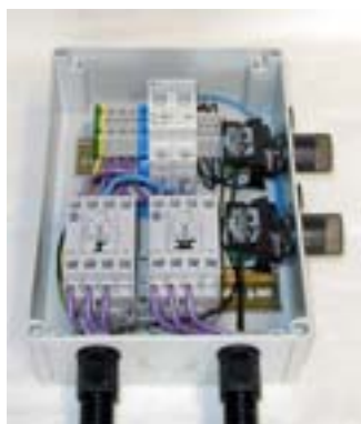
Bilde viser kontaktorskap for 14 kW
